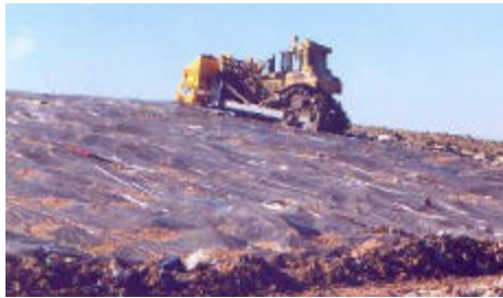
Fig. 6 – Cobertura provisoria con film biodegradable. Fig. 7 – Descarga tradicional por placa expulsora (trailer al frente) y descarga con Tipper (trailer al fondo).
