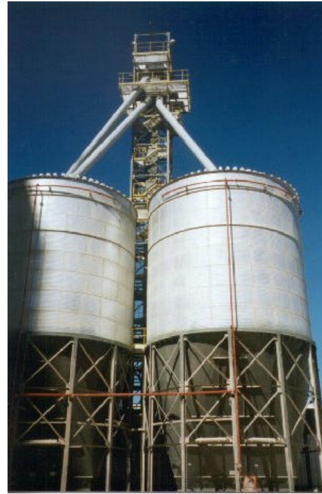
Instalación de cáscara de girasol
