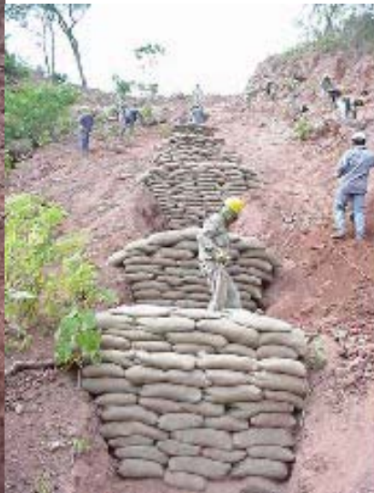
Durante la Obra Enero 2002
