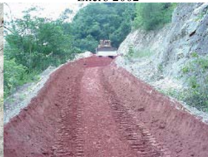
Durante la Obra Enero 2002
