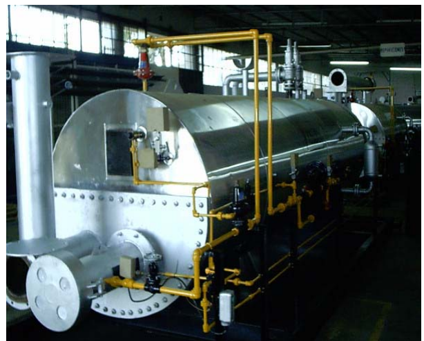
Calentadores Indirectos de Gas de 500.000 y 1 MM BTU/h: Empresa Prema Cía. del Sur
