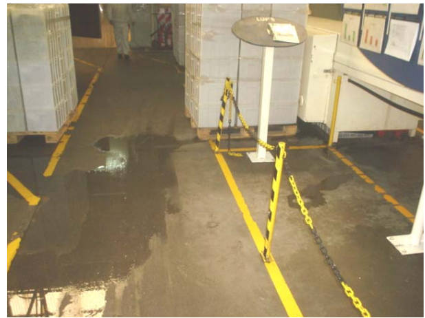
Foto 9: Pérdidas de vapor y agua en equipos
