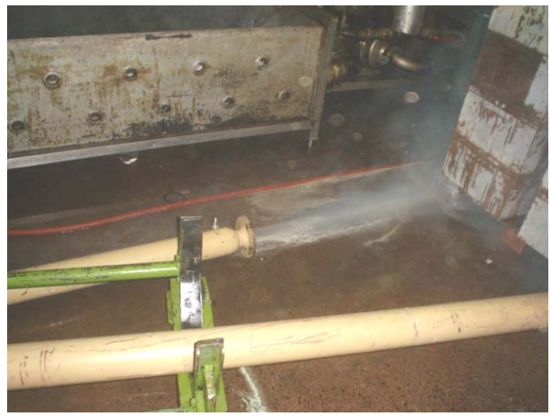
Foto 3: Uso de aire comprimido para barrido de cañerías
