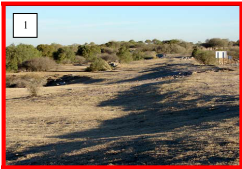
Nivelado y perfilado de superficies.
