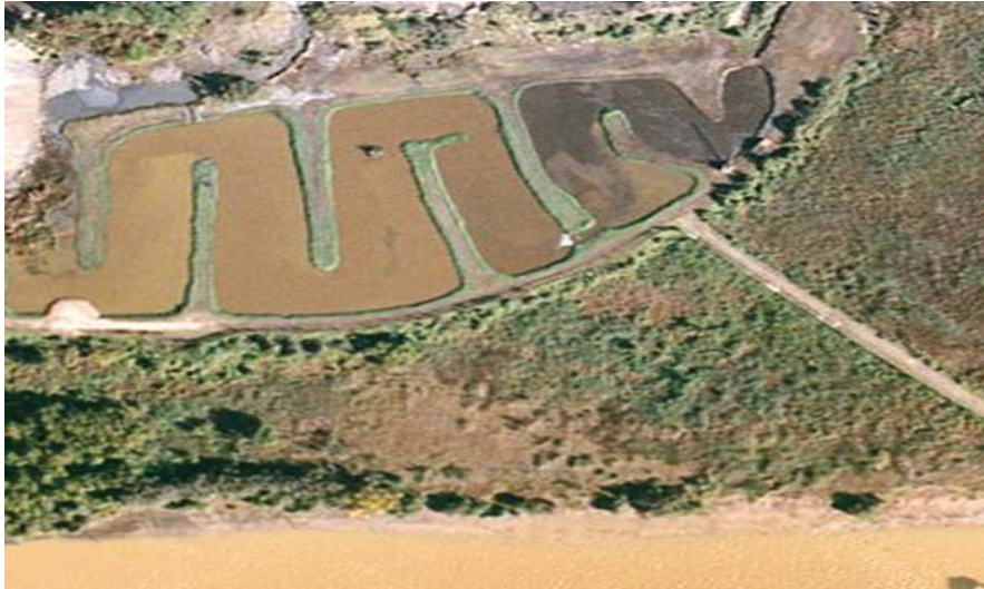
Vista aérea de la laguna de sedimentación.
