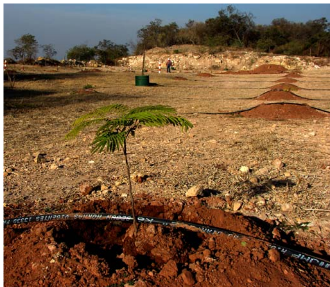
Fig.5 Piso de cantera La Bandera en proceso de rehabilitación. Ejemplar de Cebil ( Anadenanthera colubrina ) y sistema de riego por goteo. Foto 08-2008. Inicio Tareas 11-2007.
