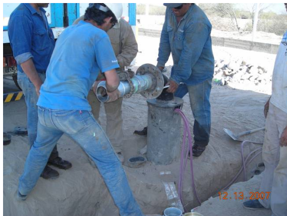
Montaje cabezal pozo de Huaco
